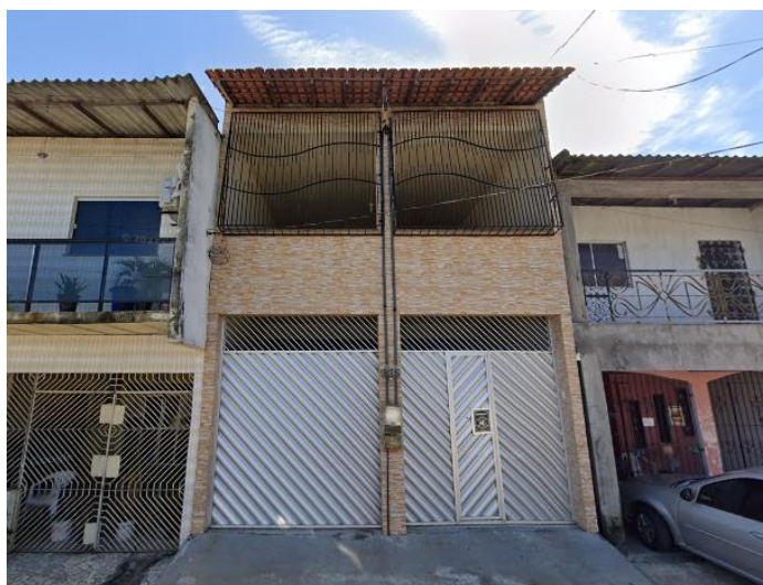
Figura 21: Casa 05 - região metropolitana de Belém, externa.
