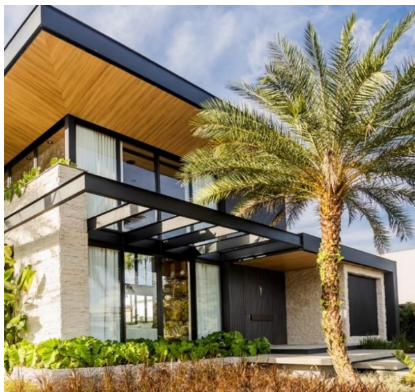
Figura 17: Casa 03 - região metropolitana de Belém, externa.
