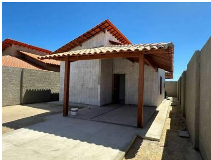
Figura 19: Casa 04 - região metropolitana de Belém, externa.
