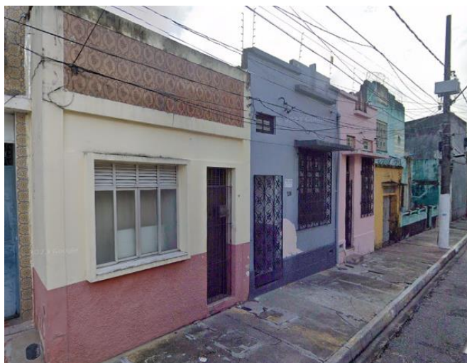
Figura 23: Casa 06 - região metropolitana de Belém, externa.
