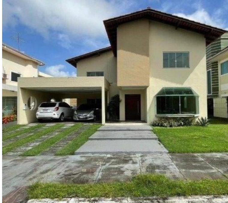
Figura 15: Casa 02 - região metropolitana de Belém, externa.
