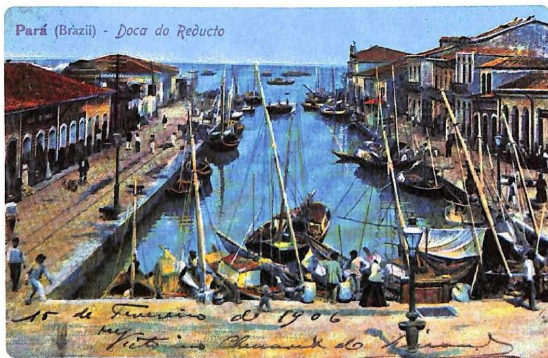
Figura 57 - Imagem da Doca do Reducto no início do século XX, Fonte: Belém da Saudade
