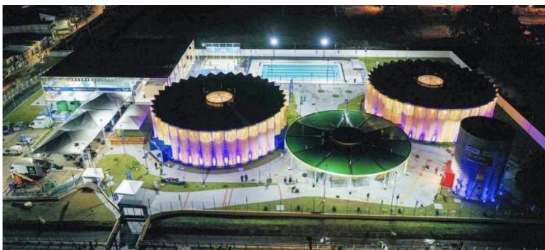
Figura 12 - Usina da Paz localizada no bairro de Terra Firme, Belém – PA.
