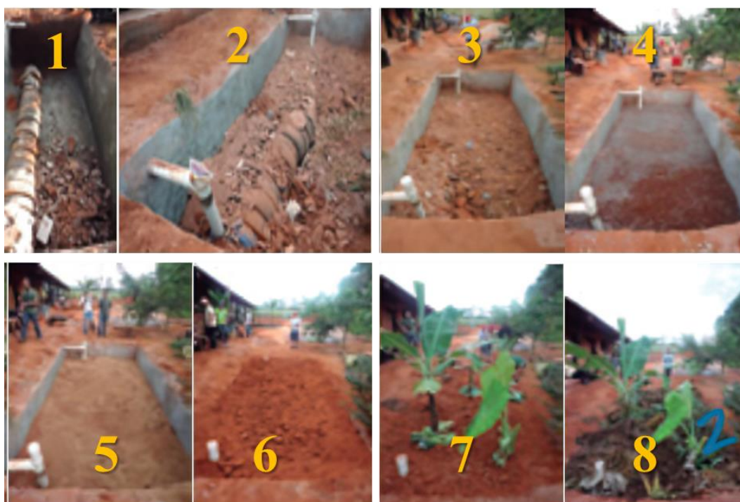
Figura 58: Bacias de evapotranspiração. As imagens estão numeradas (1 a 8) para indicar a sequência de construção das bacias.
