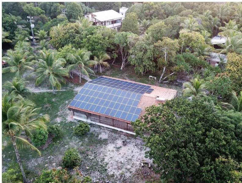
Figura 19: Sistema de geração de energia solar da Pousada Lagoa do Cassange.
