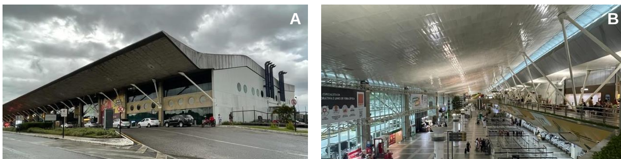
Figura 13: Terminal de passageiros do aeroporto Val de Cans, sendo (A) a fachada frontal, com fechamentos translúcidos protegidos por um grande beiral; e (B) o lado interno do edifício, contendo totens, responsáveis pela iluminação artificial, um extenso shed e fechamentos translúcidos (Autoria da foto: Thiago Sanjad).
