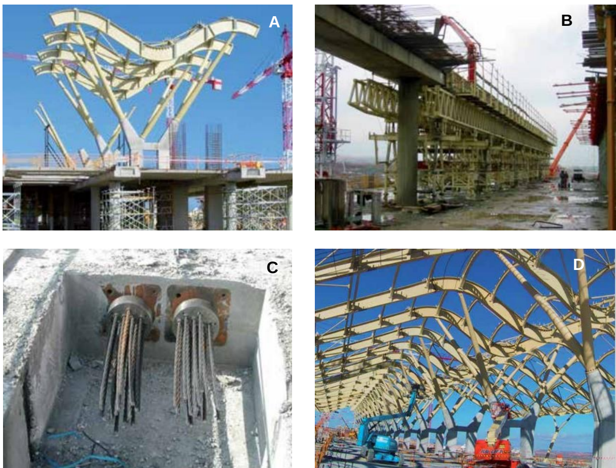
Figura 14: Elementos estruturais do aeroporto de Madrid, sendo (A) e (D) vigas e pilares metálicos; (B) as vigas e pilares em concreto; e (C) as cordoalhas de aço tracionadas (Fonte: Peiretti, 2014).
