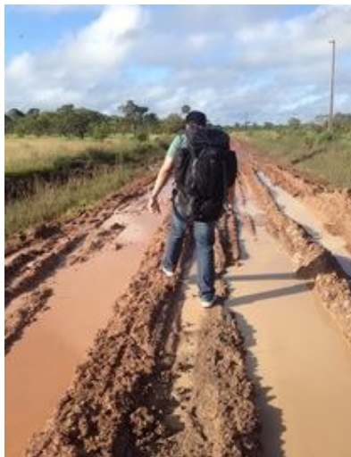
Imagem 2: Parte da Estrada de acesso a Comunidade
