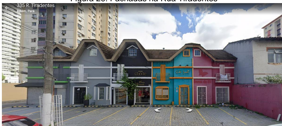
Figura 26: Fachadas na Rua Tiradentes
