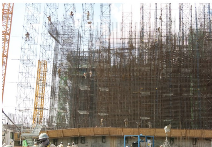
Operários trabalhando em altura (Foto: MPT, 2013)
