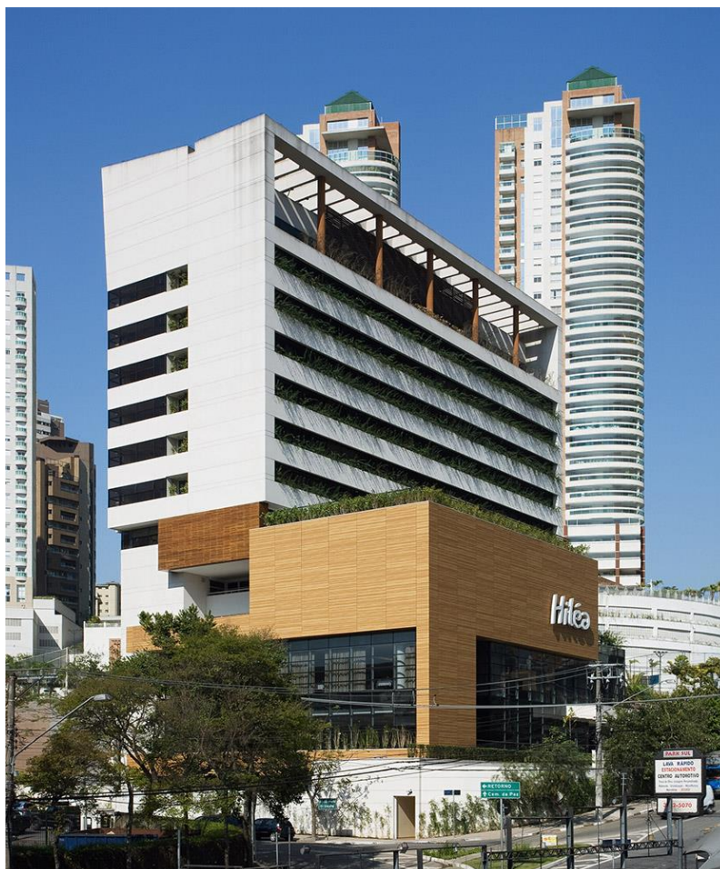
Figura 12 - Fachada 02 - Hiléa, Centro de Vivência e Desenvolvimento de Idosos.
