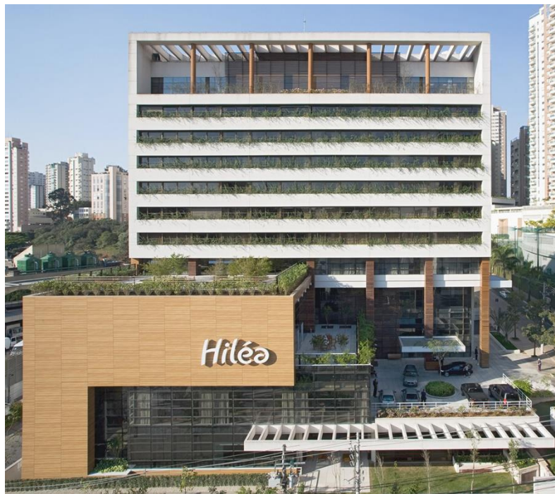
Figura 11 - Fachada 01 – Hiléa, Centro de Vivência e Desenvolvimento de Idosos.
