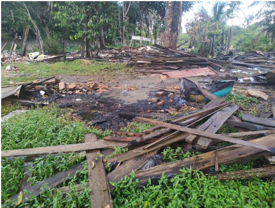
Figura 2: Escombros de madeira
