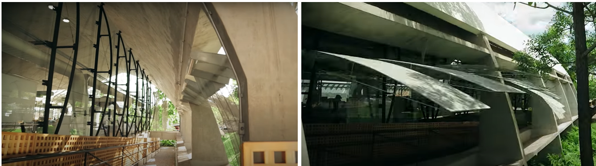
Figura 20: Iluminação natural e brises móveis
