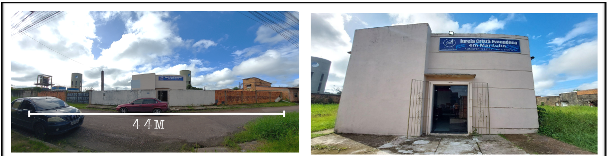
Figura 26: fachada da igreja existente
