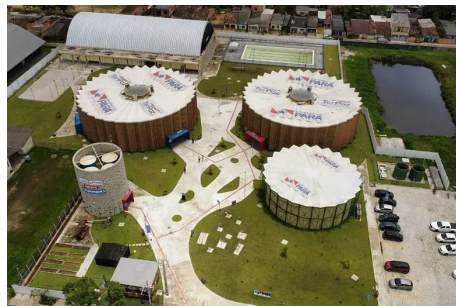
Figura 21: Usina da Paz da Cabanagem
