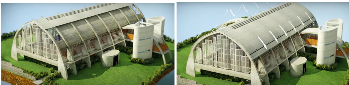
Figura 19: Duas cascas e sistema de captação da chuva
