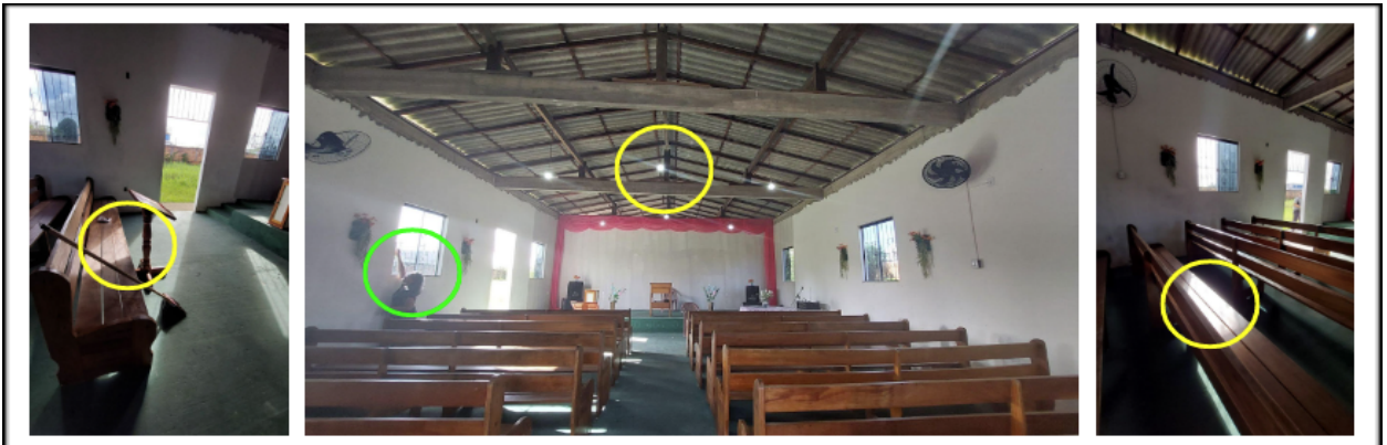
Figura 29: mostra a altura exagerada do peitoril da janela (verde) e os poucos pontos de luz artificial e manchas solares (amarelo)
