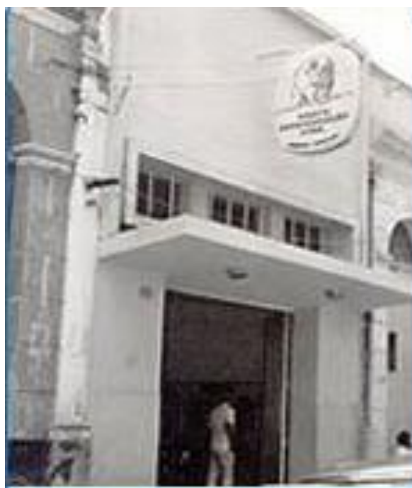
Figura 16: Fachada da primeira loja
