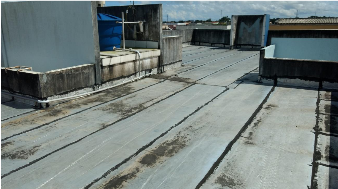
Figura 20 – Telhado a ser instalado os painéis fotovoltaicos
