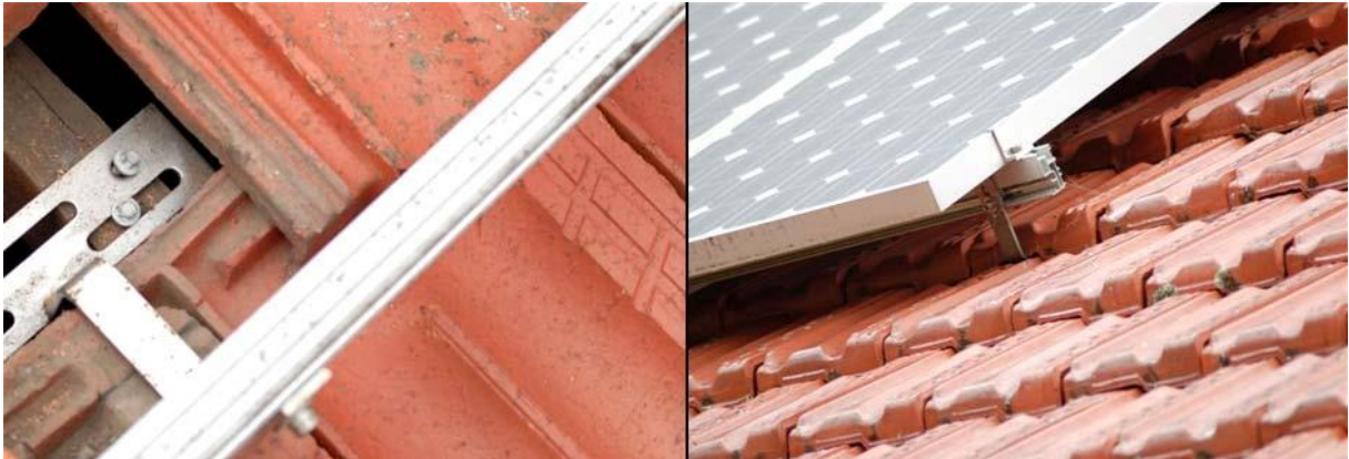
Figura 9 – Fixação interna para fixador em telhados de barro inclinados
