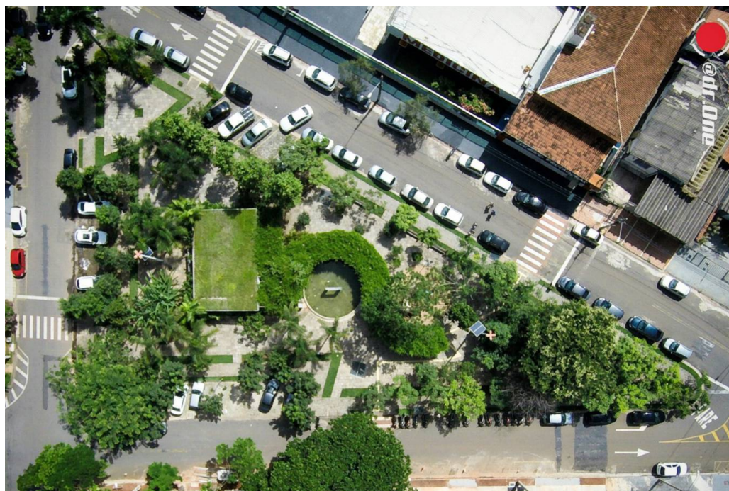
Figura 09 - Vista superior da praça após a execução do projeto
