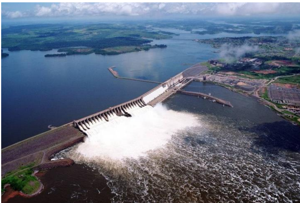
Figura 2- Vista da Usina Hidrelétrica de Tucuruí (UHT), mostrando parte do reservatório durante o período de cheia. Fonte: Cintra (2009).
