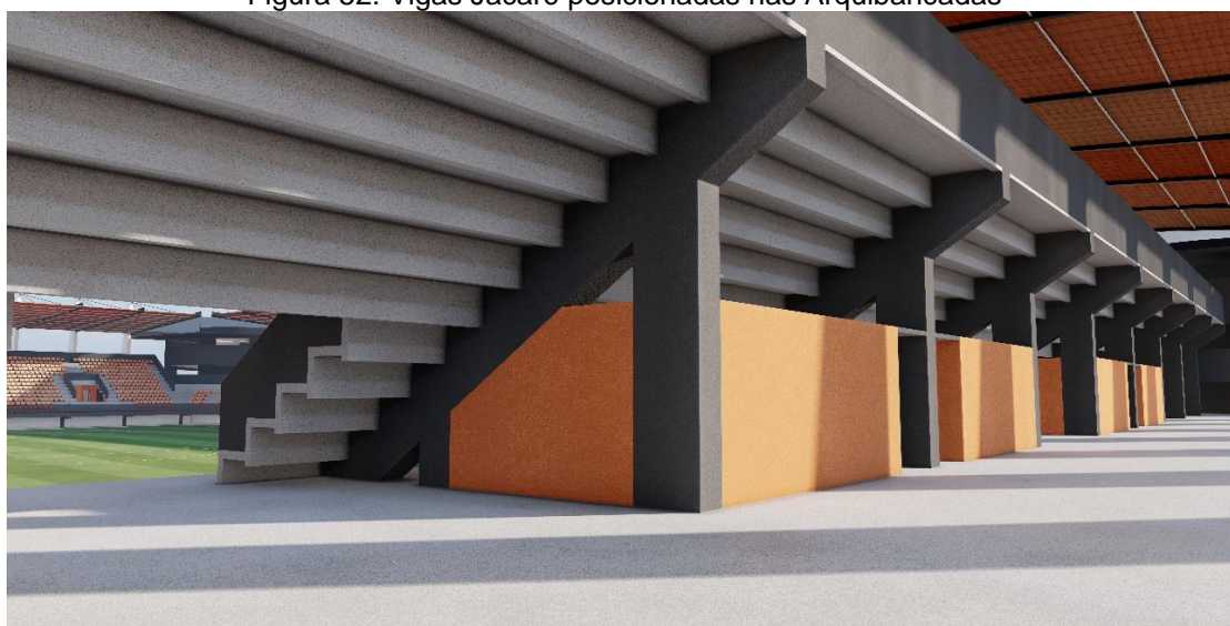
Figura 52: Vigas Jacaré posicionadas nas Arquibancadas
