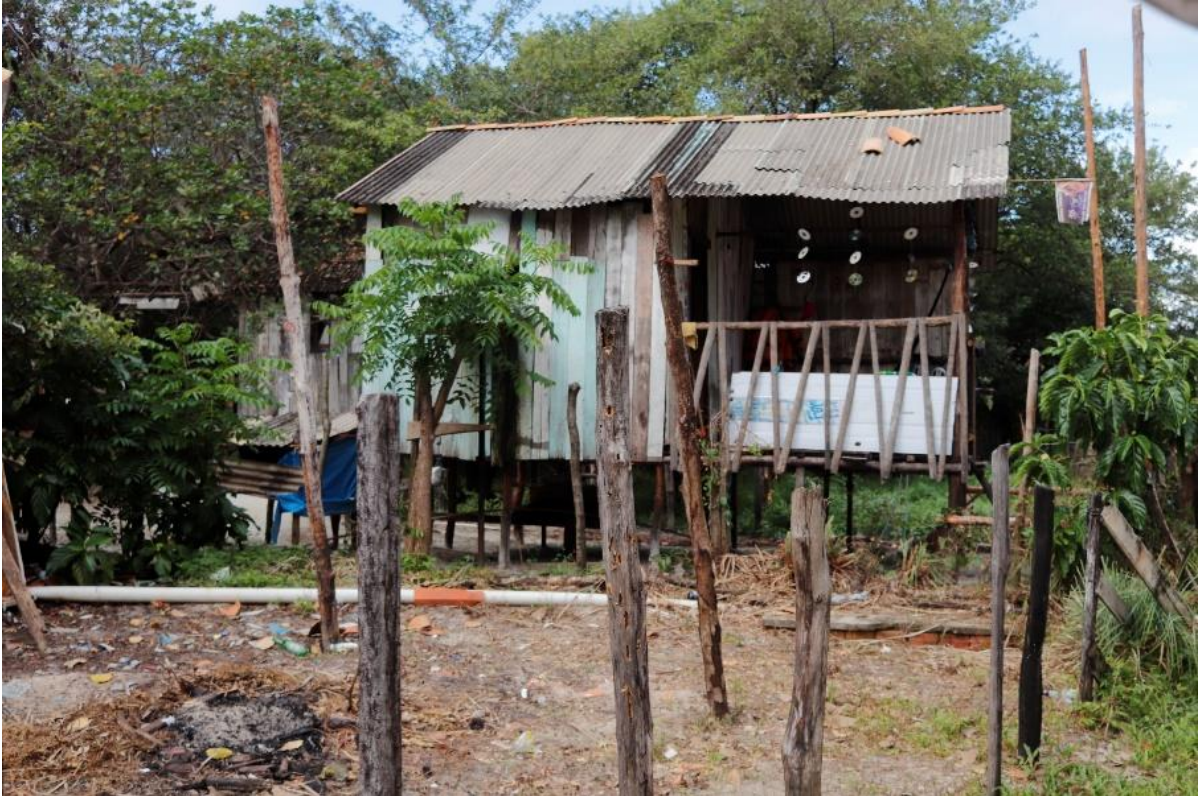
Figura 7 – Palafita com tubulações expostas sobre área de mangue na Baixada Fluminense
