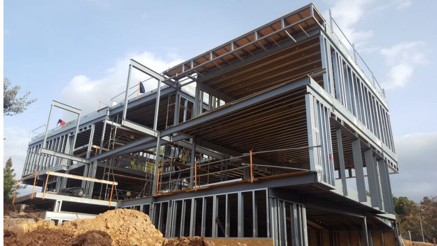
Figura 6: Construção civil utilizando sistemas modulares industrializados de aço.
