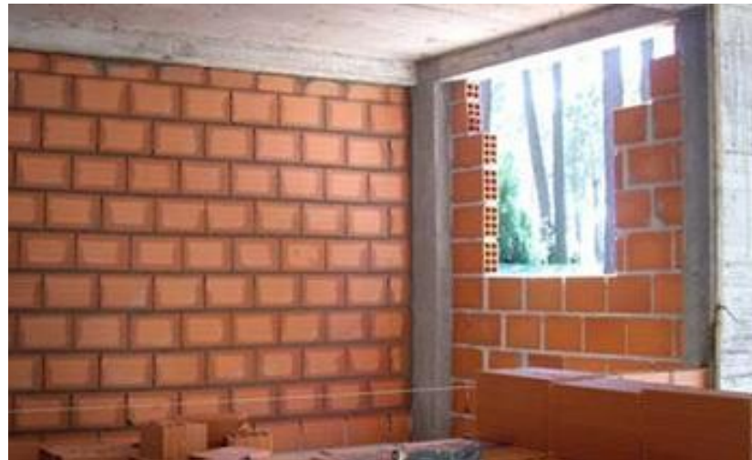
Figura 10: Vedação em Bloco Cerâmico.
