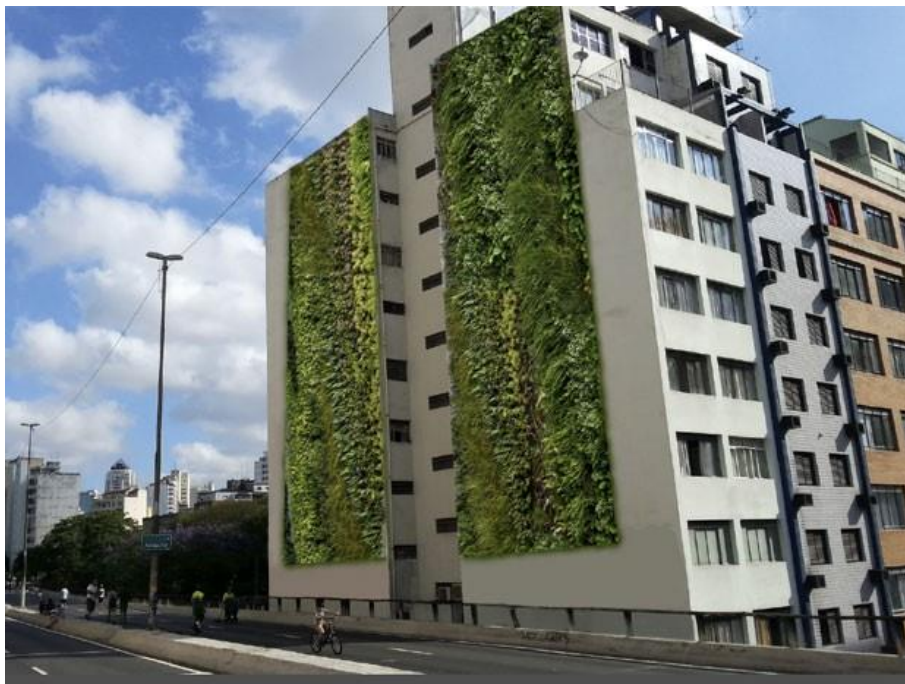
Figura 15 - Revestimento verde em edificações
