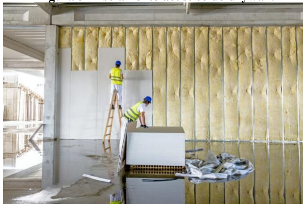
Figura 3 – Isolamento acústico do drywall.
