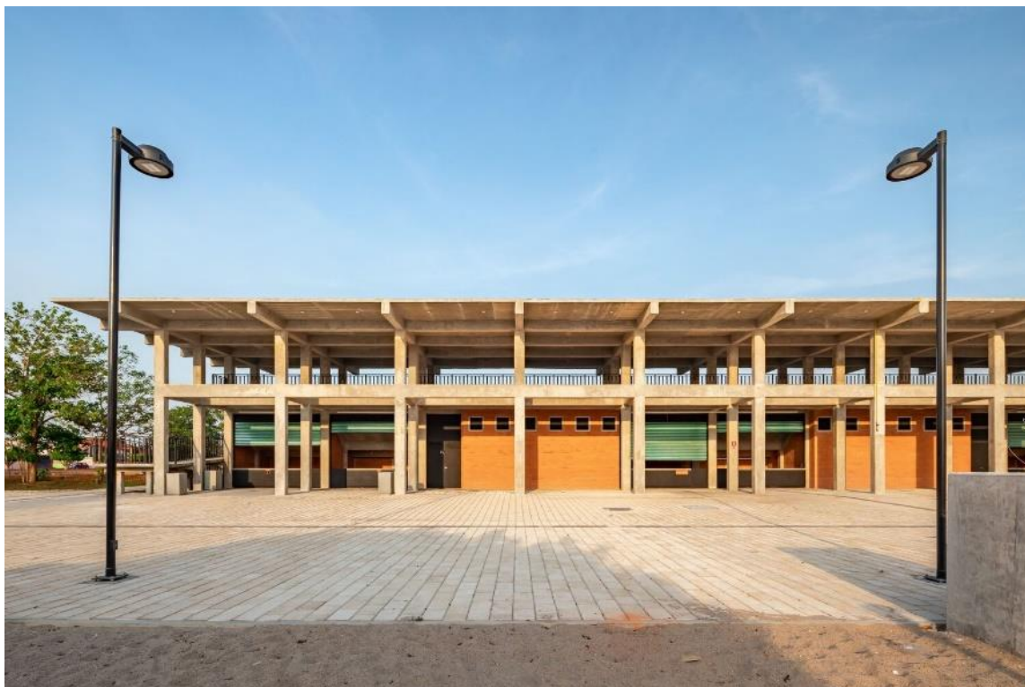
Fig. 12. Estrutura aparente da arquibancada.
