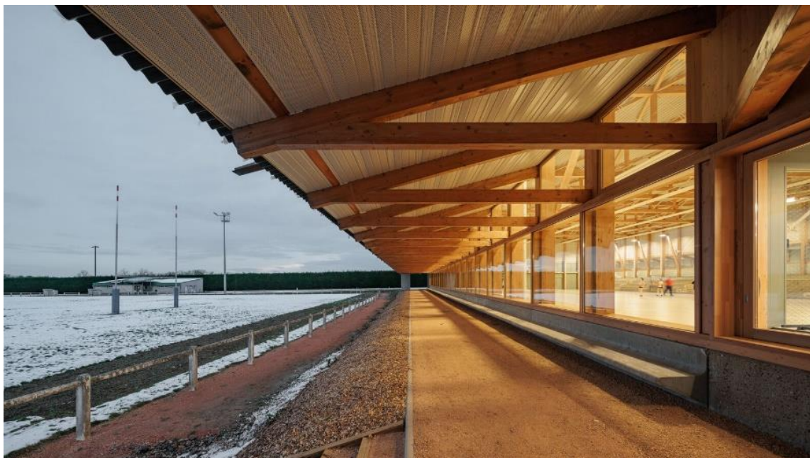
Fig. 10: Galeria do ginásio do centro esportivo Colín
