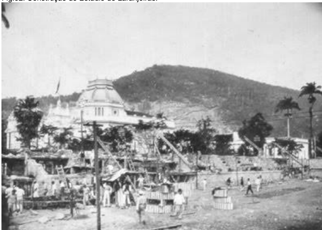
Fig.02: Construção do Estádio de Laranjeiras.
