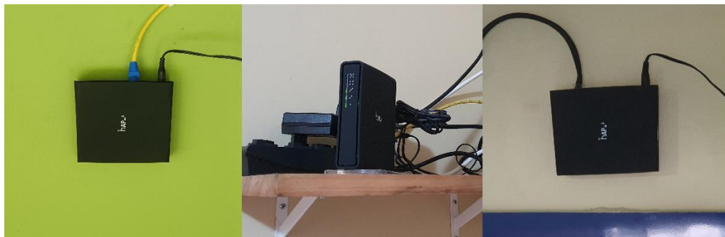
Figura 25 - Instalação dos Aparelhos Mikrotik
