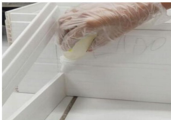
Figura 18: Acabamento da estrutura com cola de silicone
