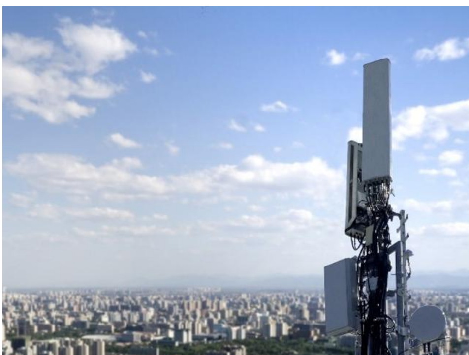
Figura 17 - Antena com Tecnologia " Massive-MIMO "
