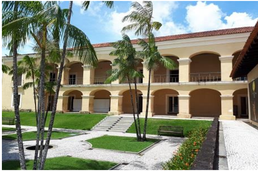
Figura 70 - Visita de campo Casa das Onze Janelas
