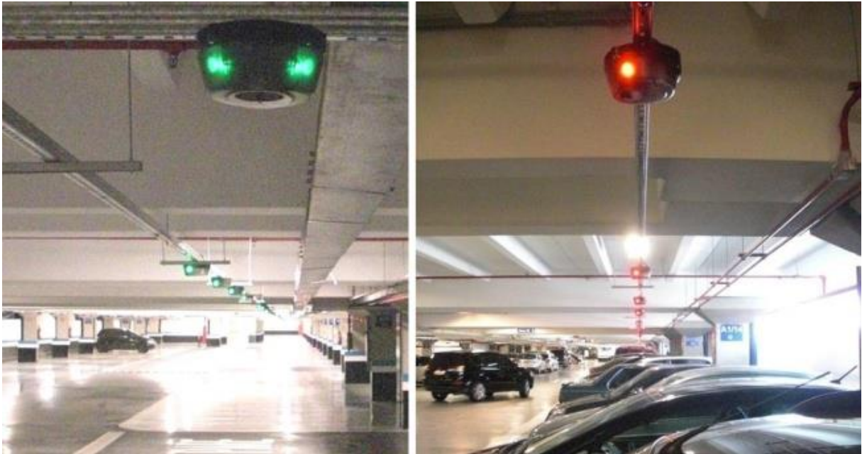
Figura 20 – Estacionamento Morumbi Shopping
